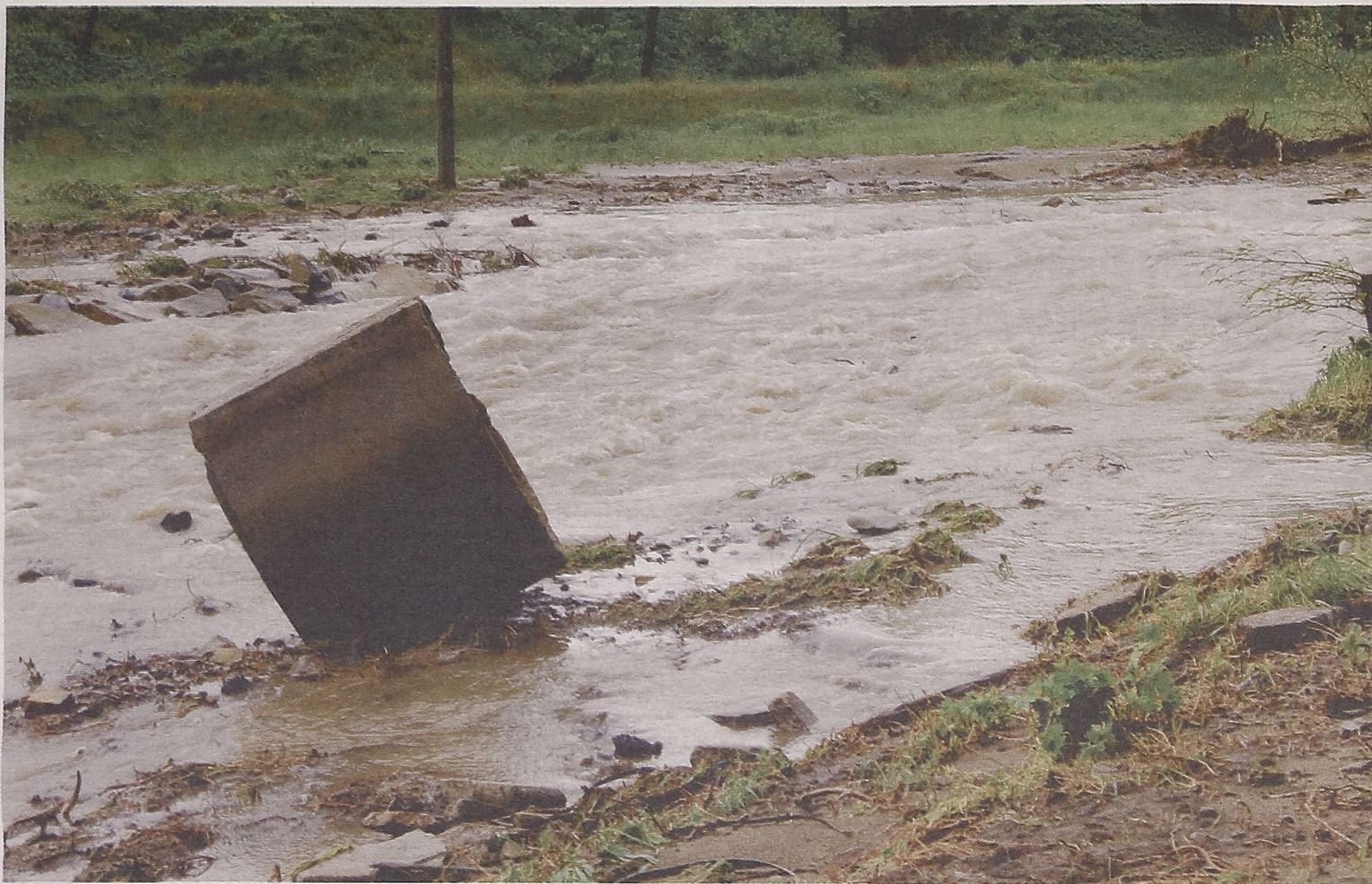
Tak wygląda świeżo umocniony brzeg Strwiąża w ustrzyckim Parku Pod Dębami
