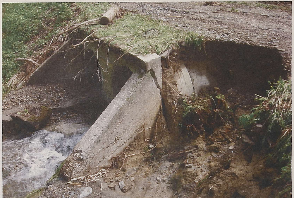
Podmyty przepust przy leśnej drodze
