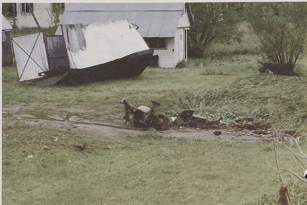
Zniszczony przez wodę garaż w Krościenku
