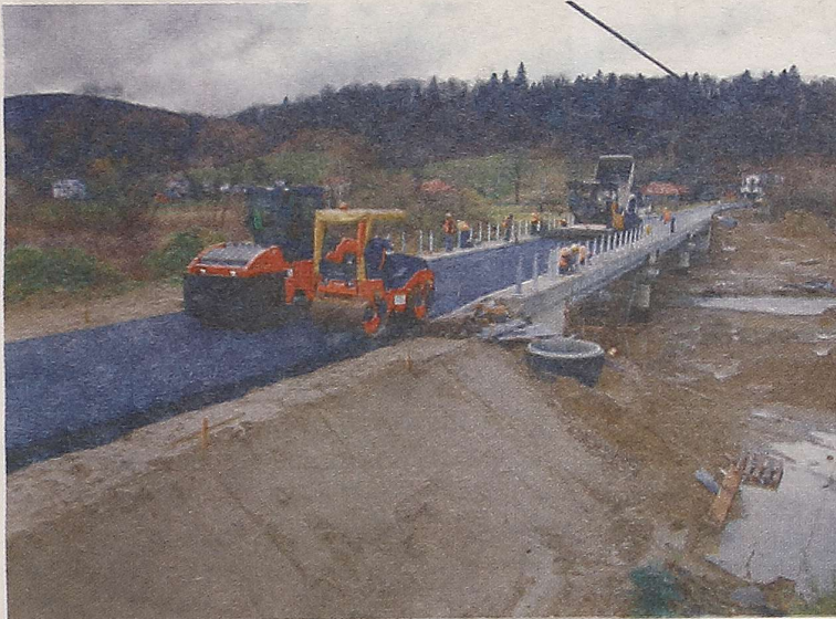
Końcowy etap budowy mostu w Myczkowcach
