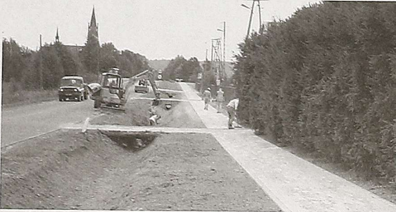
Prace przy budowie chodnika dobiegają końca. Zgodnie z umową chodnik w połowie września ma być gotowy Fot. T. Szewczyk
