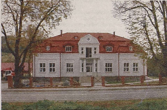
„Kuźmakówka” po remoncie
