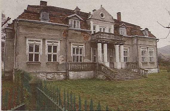
„Kuźmakówka” przed remontem
