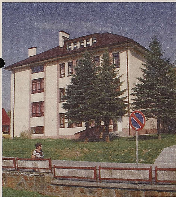
W latach 2005-2006 biblioteka została gruntownie wyremontowana
