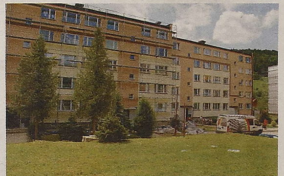
Trwają prace termomodernizacyjne na osiedlu LWSM „Drzewiarz” Fot. M. Organ
