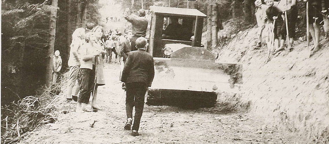
Lata 60. XX wieku. Czyn społeczny w ramach budowy wyciągu narciarskiego na ustrzyckim Gromadziniiu FOT. ARCHIWUM KRZYSZTOFA POTACZALA
