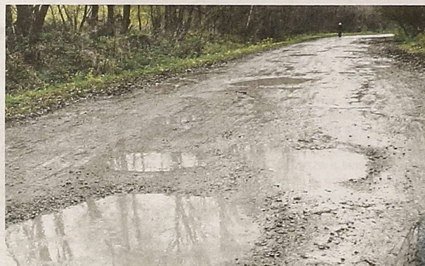
Fatalna droga do Skorodnego wreszcie zyska porządną nawierzchnię, a kierowcy przestaną narzekać na dziury i wyboje. FOT. ARCHIWUM GB
