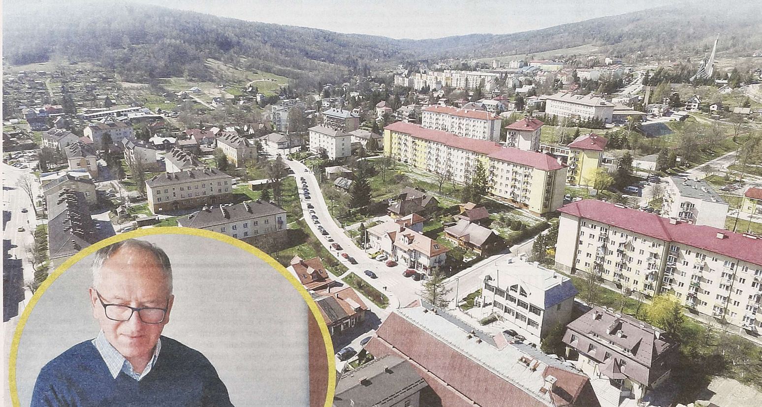
Widok na bloki przy ulicach Pionierskiej i Nowej (po prawej) FOT. ARCHIWUM UDK
